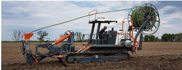
Abbildung 20: Verlegung von Erdwärmekollektoren für Agrothermie mit Spezialgerät (Fa. Doppelacker) [10]
