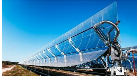
Abbildung 30: Parabolrinnenkollektoren als Großflächenanlage zur solaren Prozesswärmegewinnung [13]
