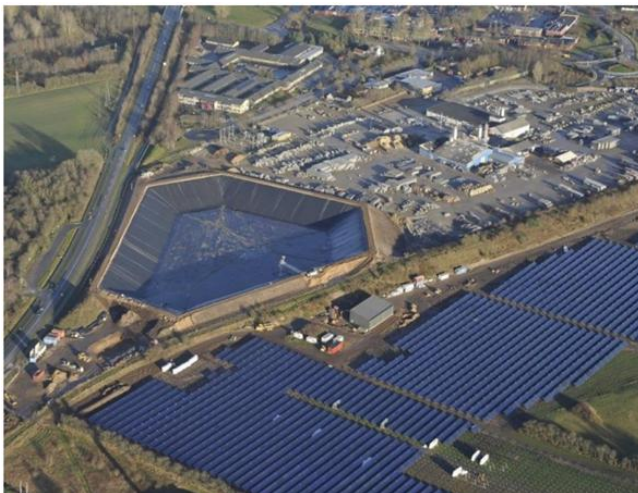
Abbildung 35: Beispiel Erdbeckenspeicher mit Solarthermie in Vojens Dänemark [16]
