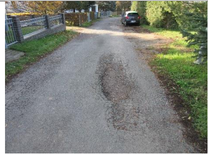
Straße An der Trift Friedrichsschwerz
