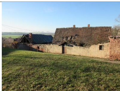
Ruinöse Gebäude Dobis (Kirchberg)
