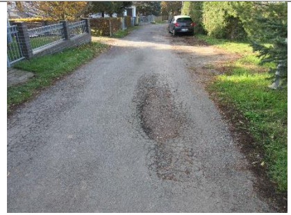
Straße An der Trift Friedrichsschwerz
