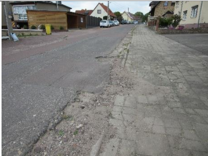
Sanierungsbedarf Könnernsche Straße einschl. Gehewege
