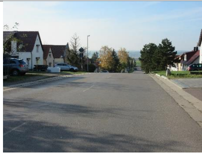
Fehlende Gehwege Coloniestraße Friedrichsschwerz
