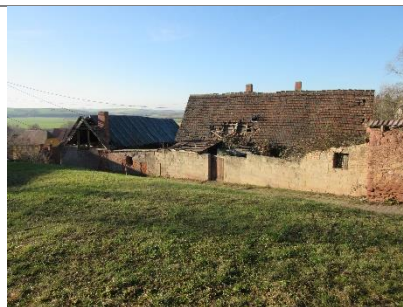
Ruinöse Gebäude Dobis (Kirchberg)
