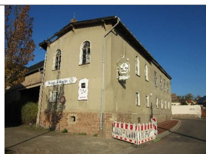
Ehem. Gaststätte Brachwitz
