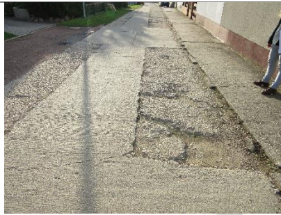
Straße Neuer Weg
