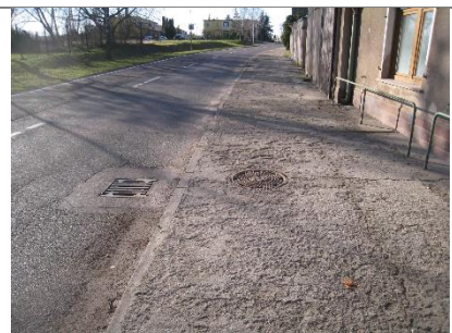
Gehwege Kreisstraße Plötz
